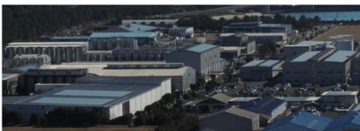
西薩中核工業団地パネル設置状況
